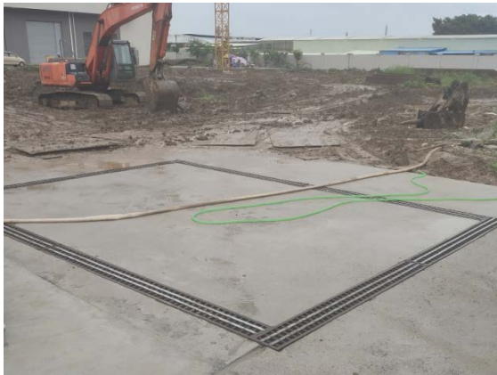
沉沙池、洗车槽
