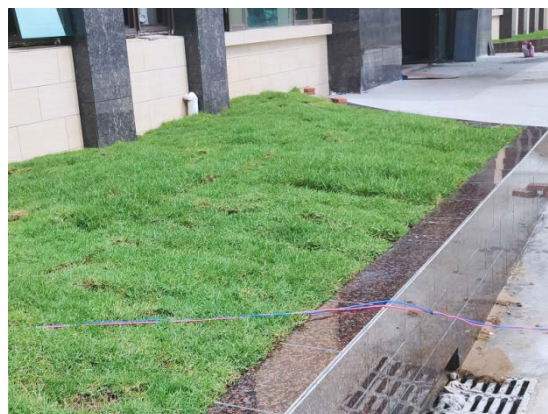
主体建筑边绿化（2021 年 4 月）
